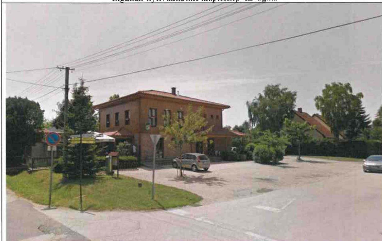
fotó a Mikszáth Kálmán utca Óvoda utca kereszteződésében található épületről forrás:google.com
