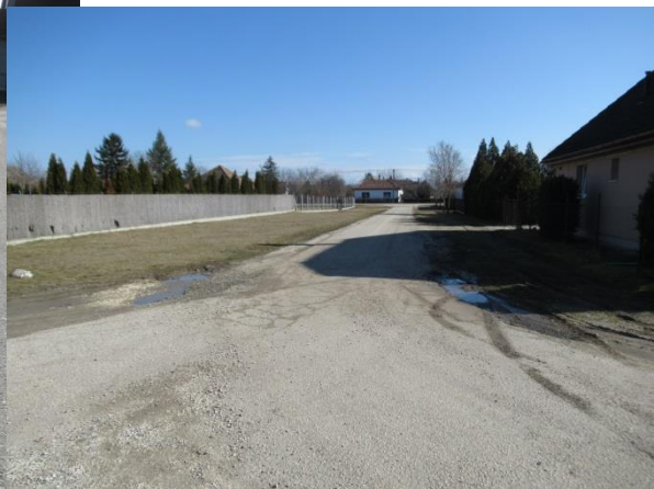
csatlakozó út leromlott állagú, kátyúzás + 1 réteg aszfalt felújítás szüks. , útdelta kitaposott
