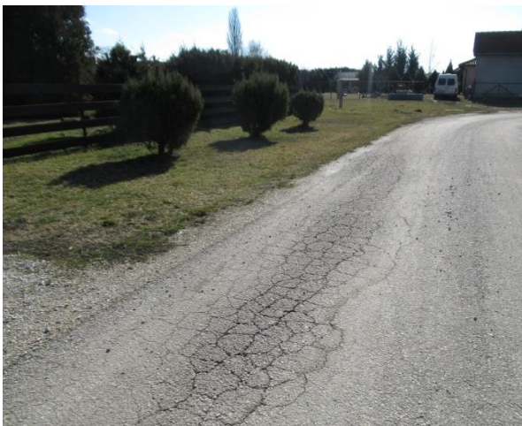
csatlakozó út leromlott állagú, kátyúzás + 1 réteg aszfalt felújítás szüks. , útdelta kitaposott
