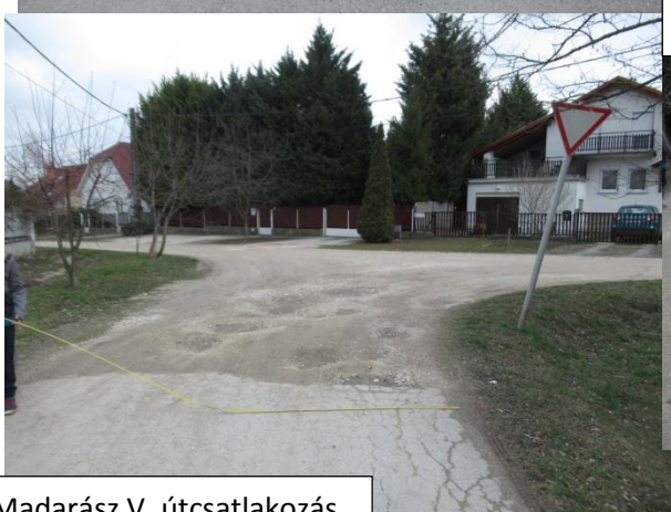
Madarász V. útcsatlakozás
